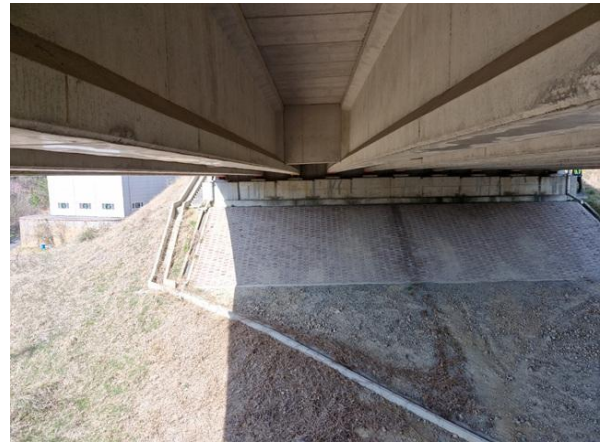
교대 A2 기초 전경
