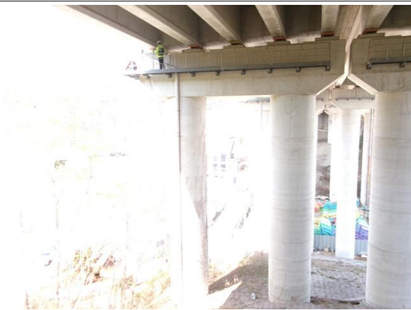
교각 P1 기초 전경
