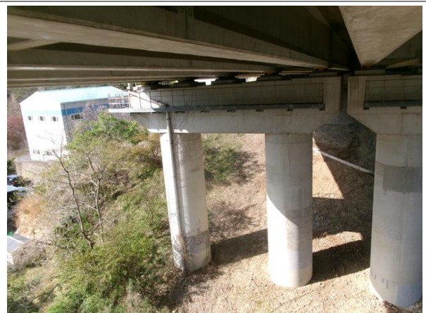
교각 P4 기초 전경
