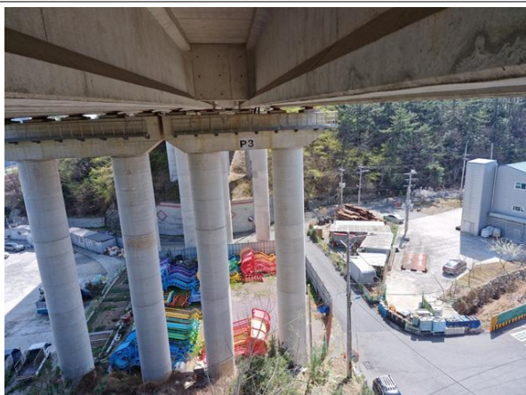
교각 P3 기초 전경
