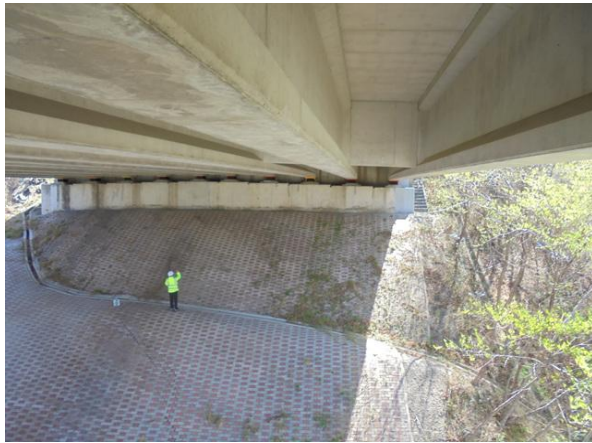
교대 A1 기초 전경
