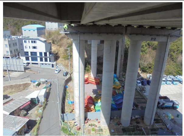
교각 P2 기초 전경
